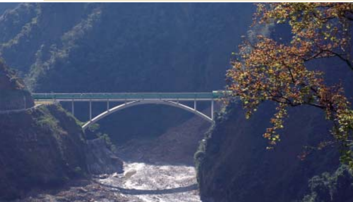
>>新武界引水隧道水管橋
