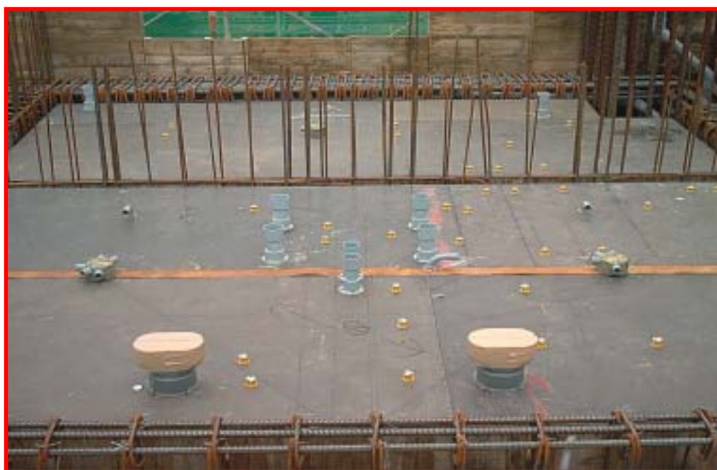
圖 1.8 模板上各類管路施工放樣
