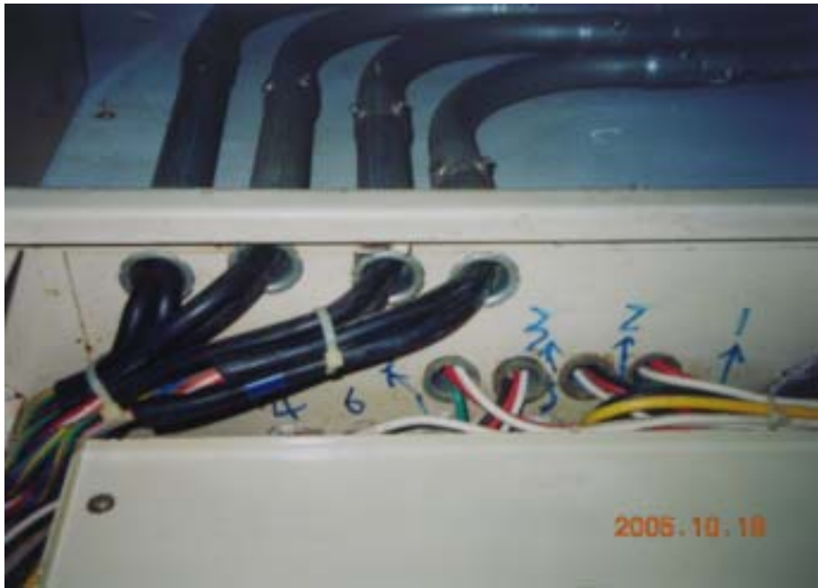
圖 1.17 電氣管路與分電箱之接續
