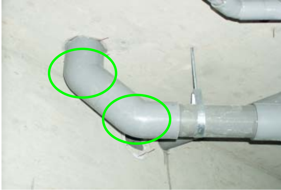
圖 1.11 污排水管路轉彎處採 2 只 45 度彎頭銜接
