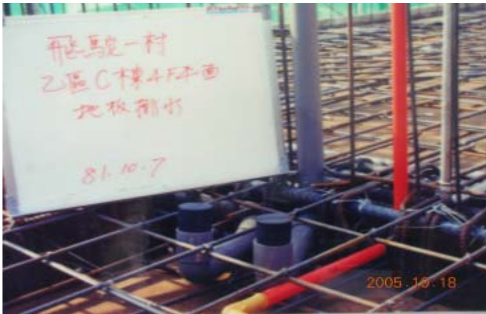
圖 1.10 各類管路施工固定及封塞
