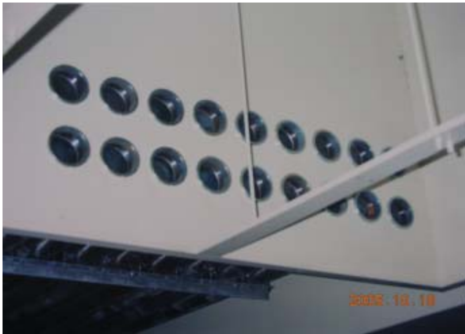
圖 1.18 電氣管路與拉線箱之接續
