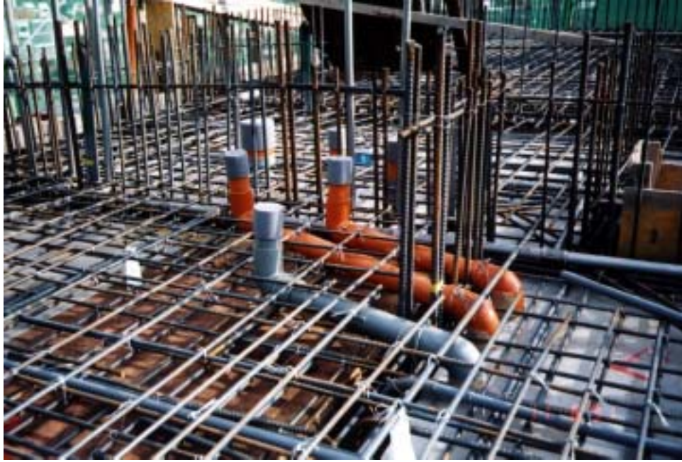
圖 1.9 各類管路施工固定於雙層鋼筋之間
