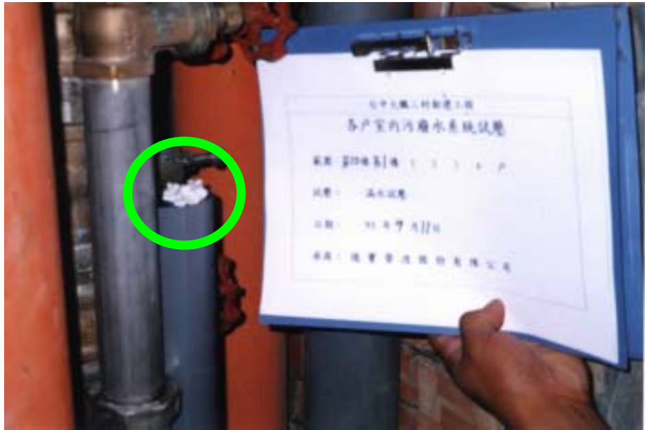
圖 1.15 污排水管路試水試壓
