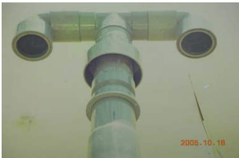
圖 1.7 屋頂過版管、泛水帽與通氣管配管
