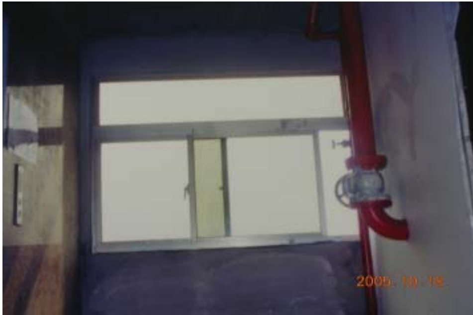
圖 1.21 消防管路配設位置影響觀瞻
