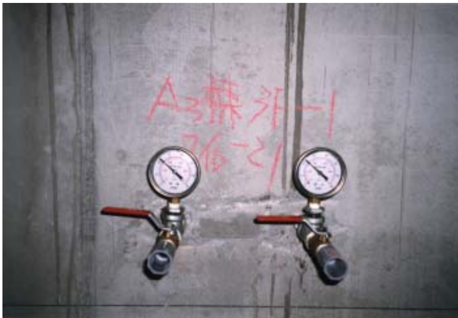
圖 1.14 牆面裝修前給水管路二度試水試壓
