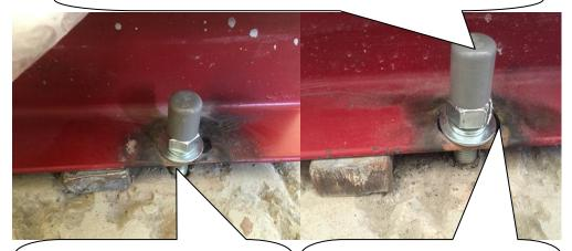
消防泵設備基座未預留固定 螺絲座,新建廠房不宜使用 化學螺栓設置固定。
