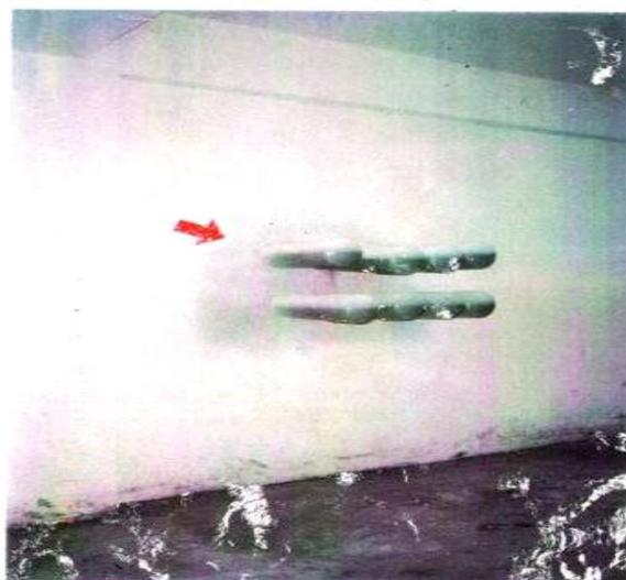
(6)不良配設實例：管路四周之外牆產生滲漏水現象。
