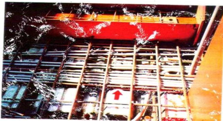
(4)正確配設實例：敷設完成之暗管出口用膠帶將管口封閉，避免灌漿時泥漿掉入管內造成阻塞。
