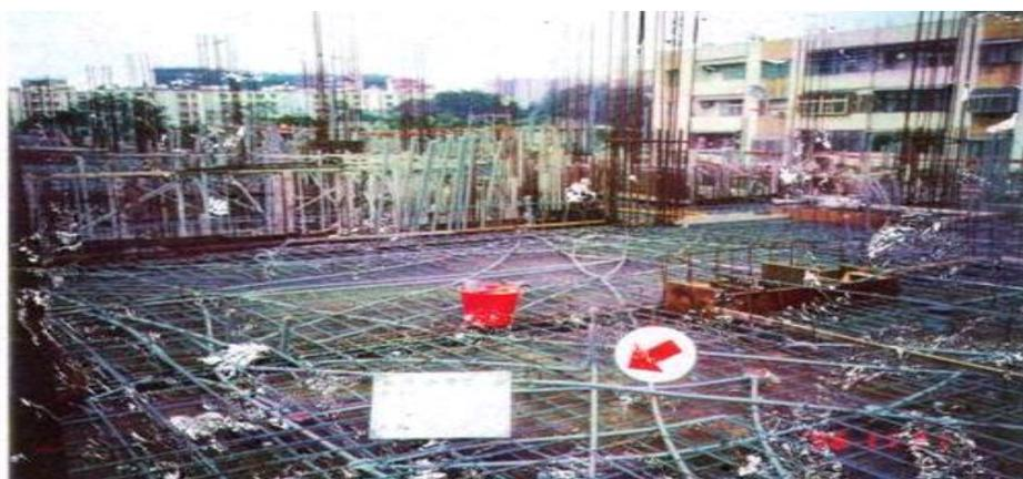
(6)正確配設實例：電管配設於柱箍筋內。
