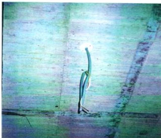
(3) 正確配設實例：樓版出線口之電線穿入浪管保護，出線口並裝設蓋板。
