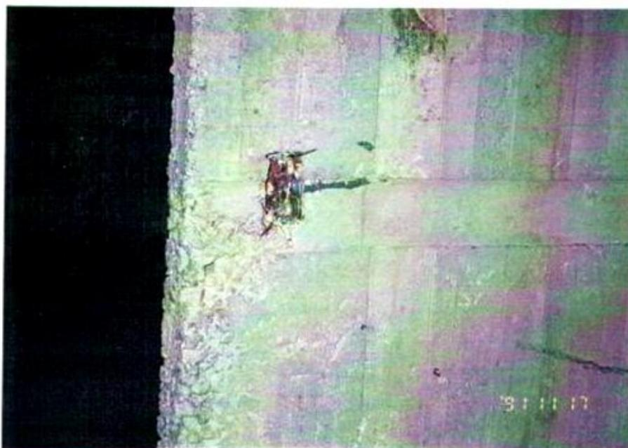
(2)不良配設實例：配管至出線匣的長度過長，且管口未施作喇叭口，這樣於穿線時，亦破壞電線絕緣披覆，造成漏電或短路的危險。
