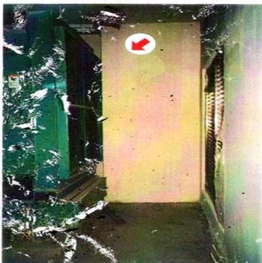
(3)不良配設實例：發電機施設不當，凸出室外佔用停車位。
