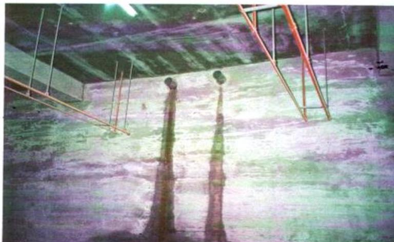
(5)正確配設實例：管口封帽且無滲漏水現象。
