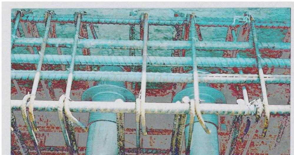
(3) 不良配設實例：穿越外牆之管路未加設止水環，易造成外牆滲漏水。
