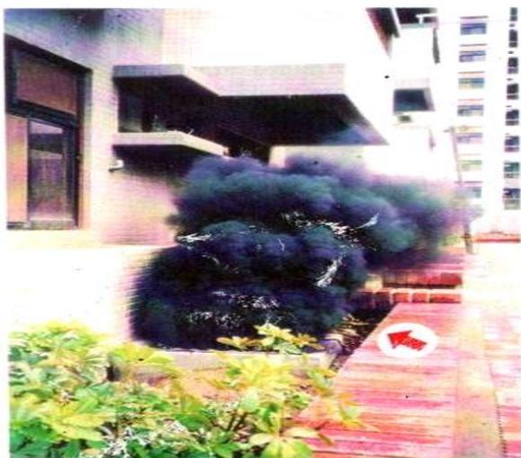
(5)不良配設實例：發電機排煙管凸出屋外部份未以隔熱材包覆。
