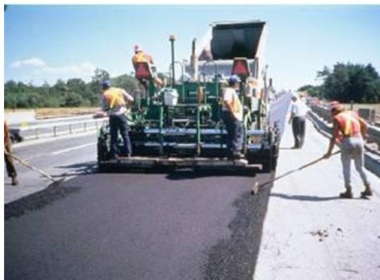
圖 22 鋪築瀝青路面
