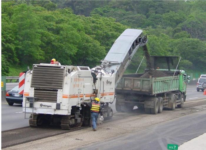
圖 29 冷式刨除機刨除損壞舊瀝青路面
