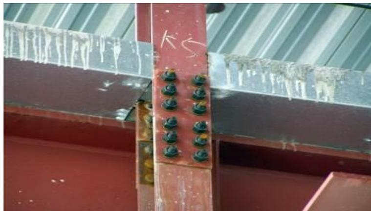
圖 3-42 混凝土澆築漏漿
