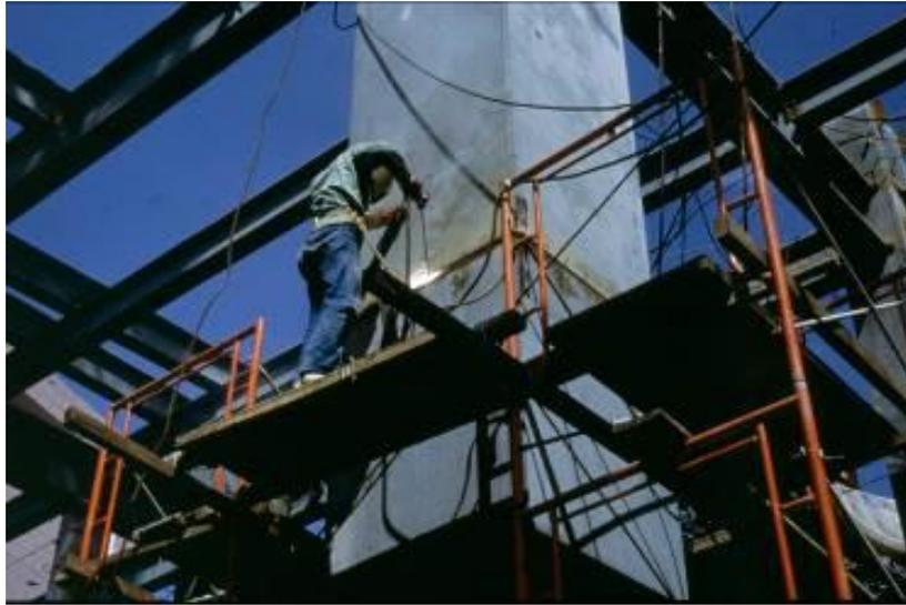
圖 3-40 鋼柱對接電銲施工
