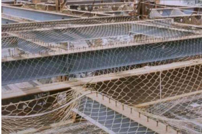
圖 3-46 一般安全網之架設
