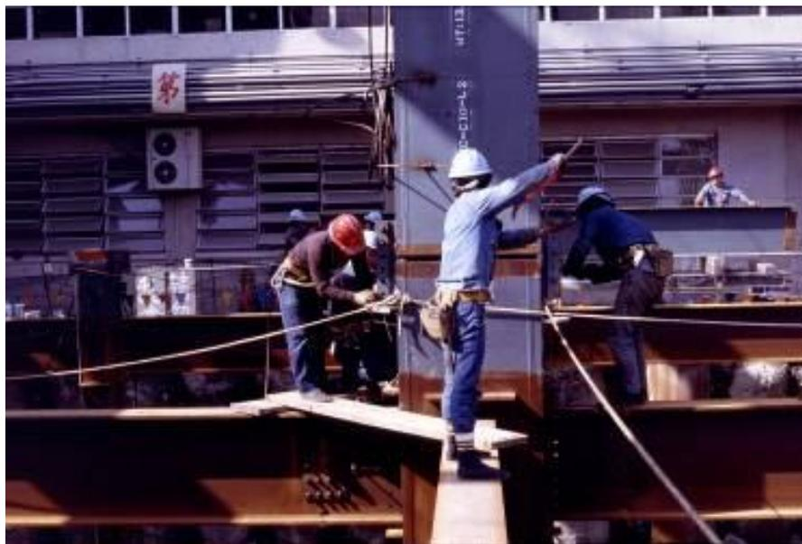
圖 3-39 鋼柱吊裝時的指揮工作
