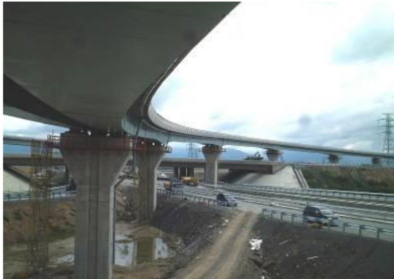
圖 3-47 鋼橋安裝完成情形
