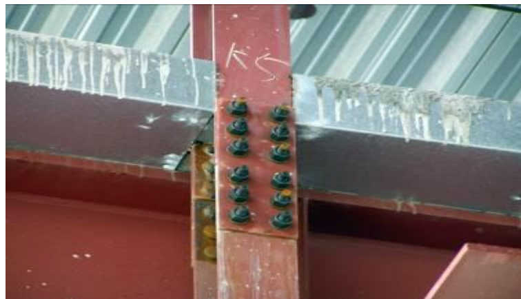
圖 3-42 混凝土澆築漏漿
