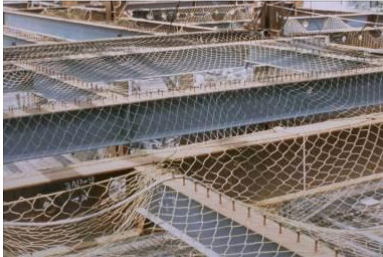
圖 3-46 一般安全網之架設
