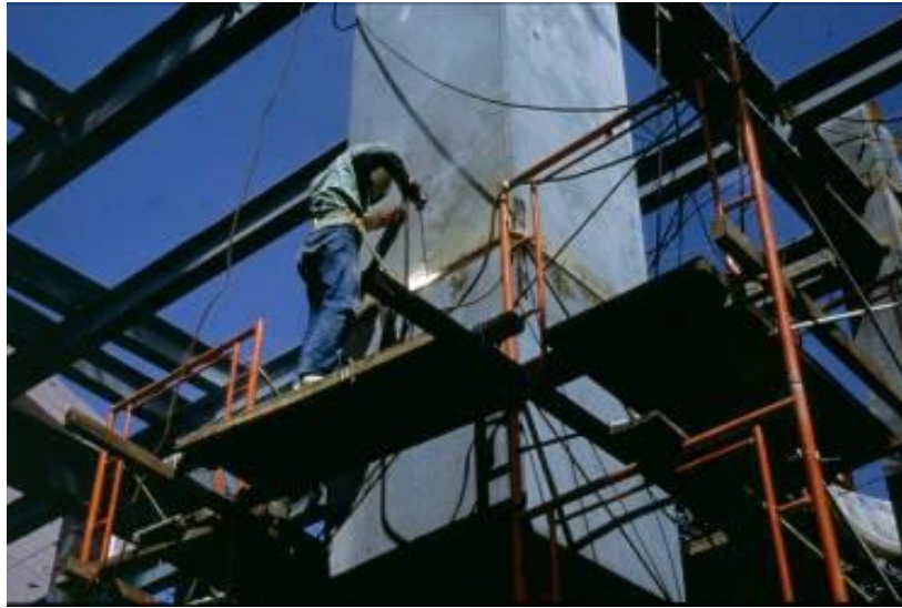
圖 3-40 鋼柱對接電銲施工
