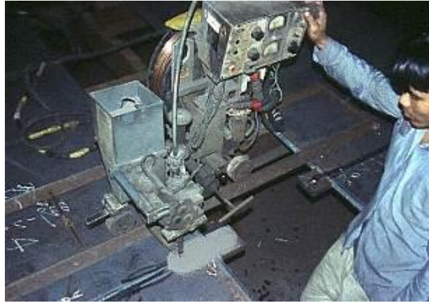
圖 13-25 SAW 銲接操作
