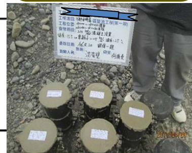
混凝土試體取樣
