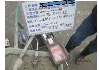
混凝土氯離子試驗
