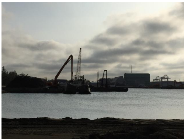
本案現場施工狀況
