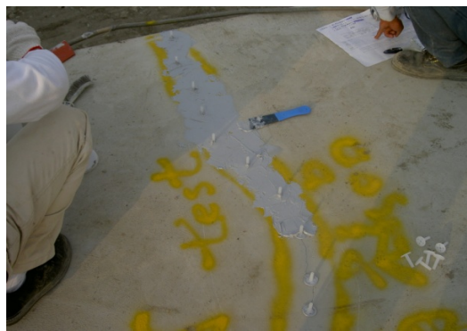
圖 7：用密封劑把裂縫的表面確實封固
