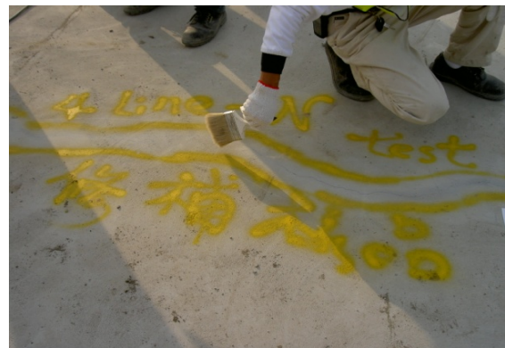
圖 4：用毛刷清潔混凝土表面
