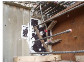
封模及密封（模板邊填縫密封）
