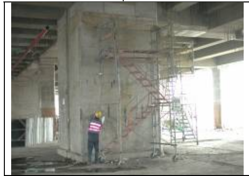
混凝土缺陷修補
