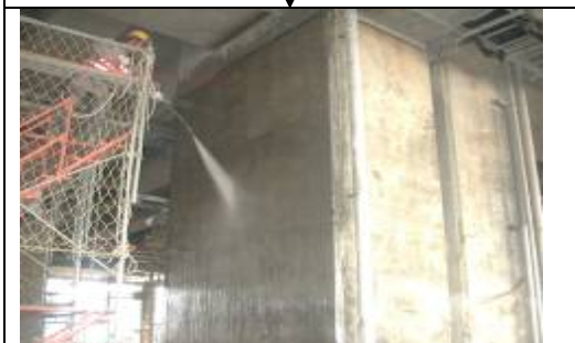
熱水高壓水柱沖洗
