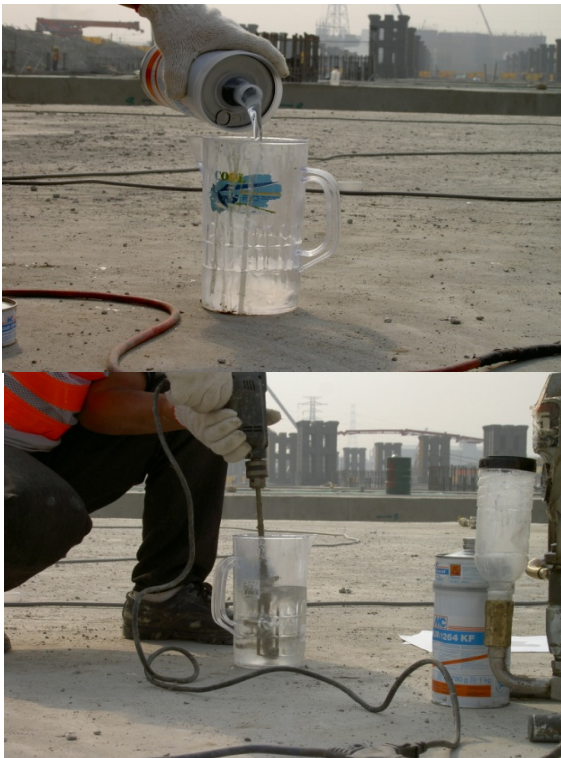
圖 8：MC DUR 1264KF A 及 B 注射劑混合
