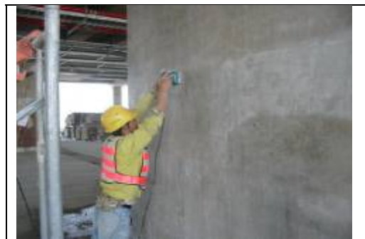
混凝土表面磨平
