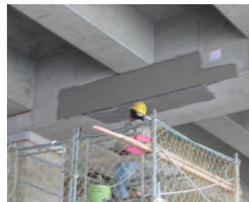
噴漿後表面鏟刀修飾 (修補材料:Nafufill KM250)(詳附件 1-1)
