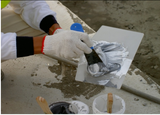
圖 5：MC-DUR SI88A 及 B 密封劑混合
