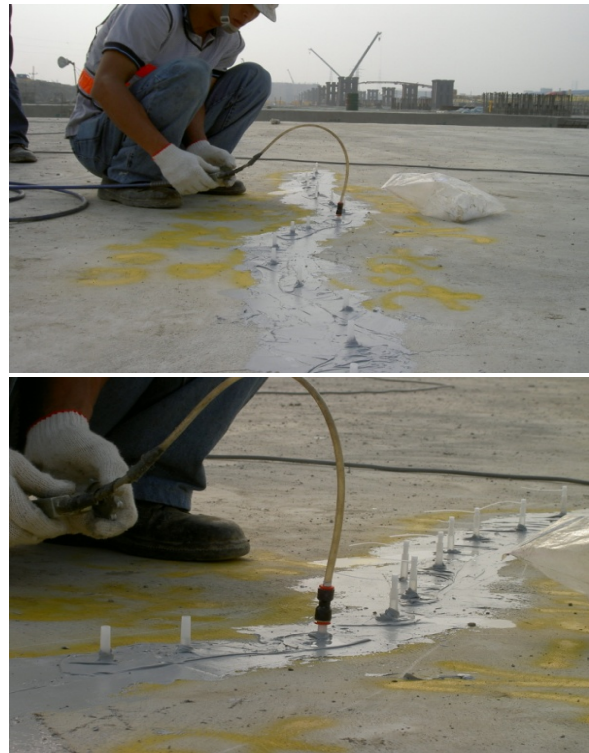
圖 9：MC DUR 1264KF A 及 B 注射
