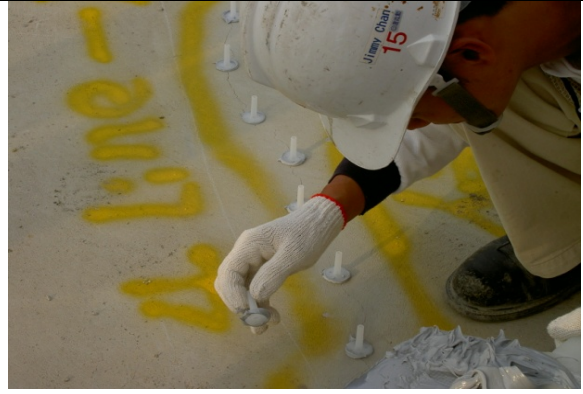
圖 6：把注射用底座安裝好，使其固定底座的中心（每 15cm 一個底座）。
