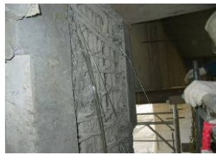
黏著劑及透氣管施作完成
