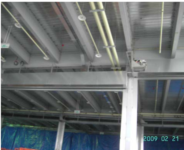
管線穿越防火區劃施工例
