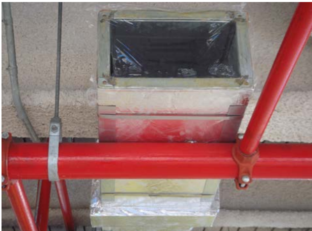
防火保溫材之施工例
