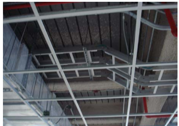
風管貼樑施工，管線爬昇例
