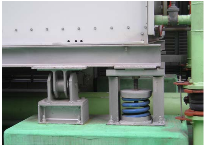
預備避震及防地震抑制施工安
