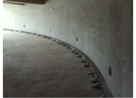
車道照明與土建施工例
