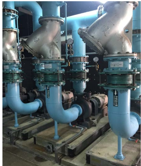
冰水主機房冷卻水泵配置例
