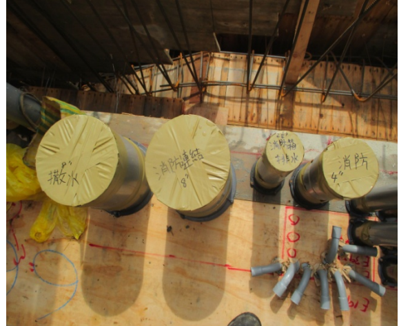
管道間採留套管方式可填塞完整
