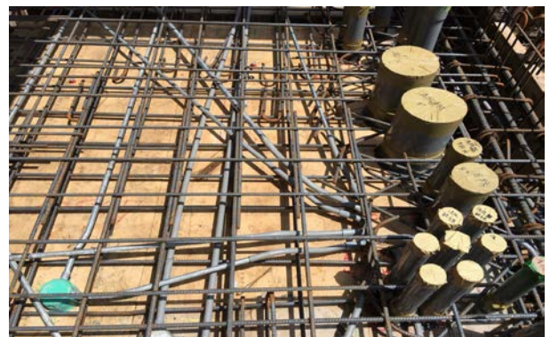
大尺寸套管預埋並加補強鋼筋
