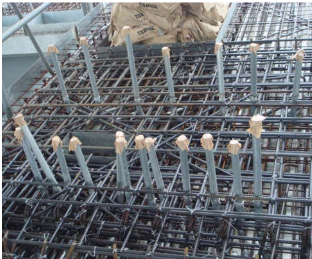
牆面配管應放樣正確施作
