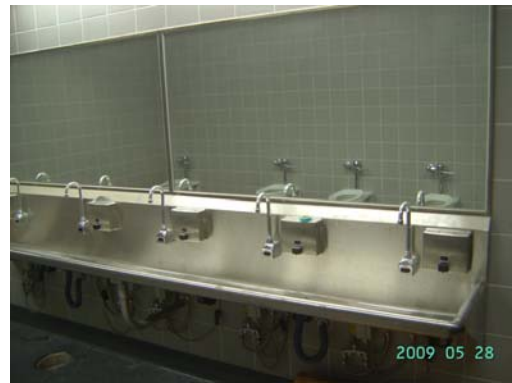
給排水管之埋設位置與高程應配合選用器具埋設
