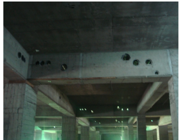
穿牆穿樑管線避免破壞建築結構強度
