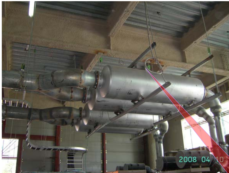
發電機之消音器安裝例
