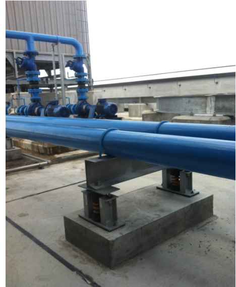
屋頂管路配置及防震施工例
