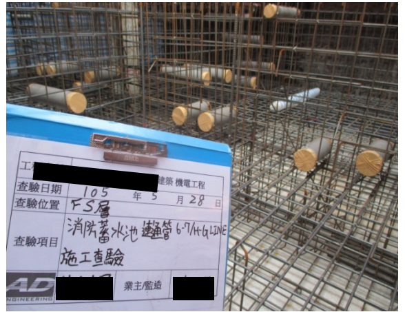
地下水池預留套管施工例
