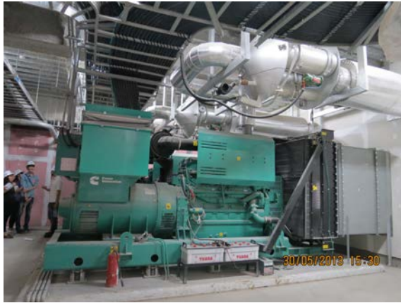
發電機組散熱及煙囪安裝例
