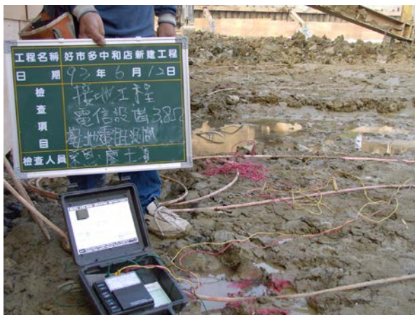
接地施工查驗例(一)
