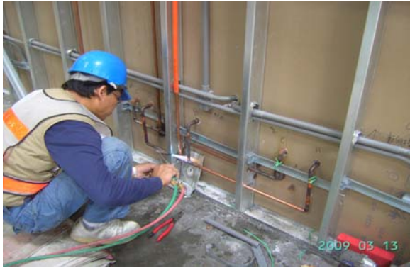
乾式牆管線施作例
