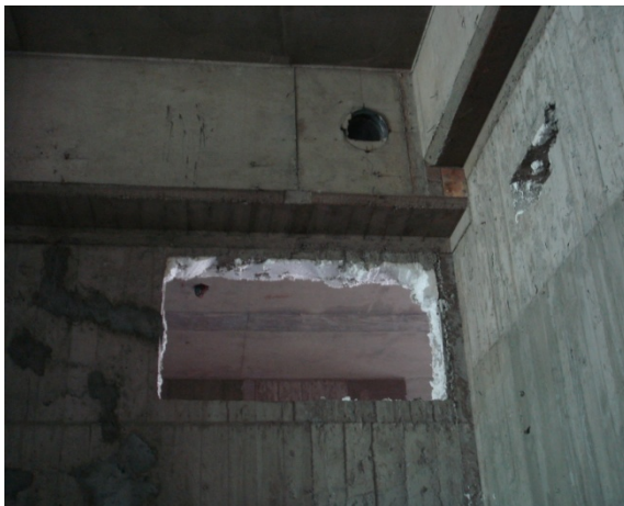
穿牆穿樑管線避免破壞建築結構強度
