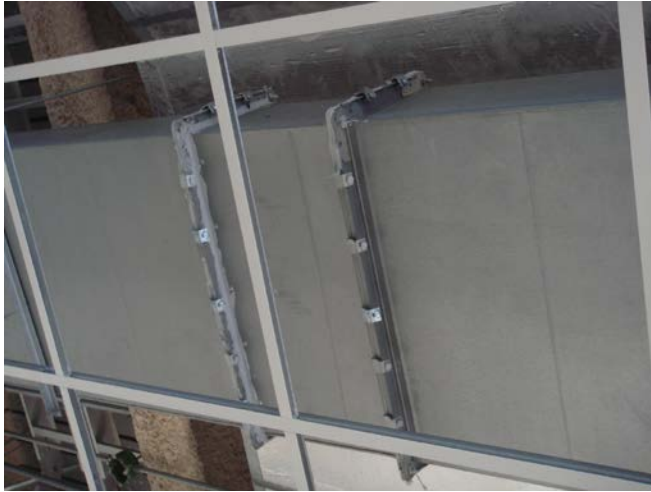
機水電壓力管線施工完成試壓
