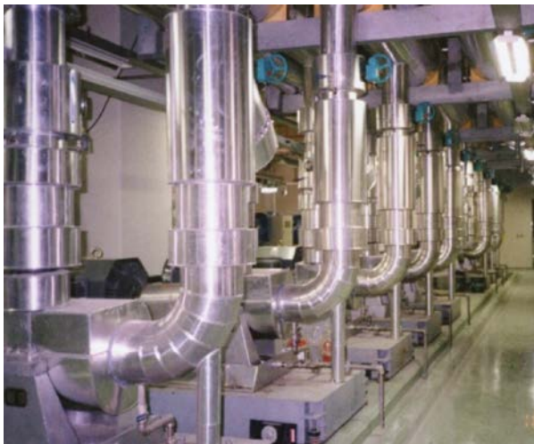
冰水主機房冰水泵配置例
