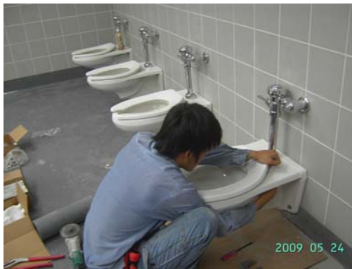
給排水管之埋設位置與高程應配合選用器具埋設
