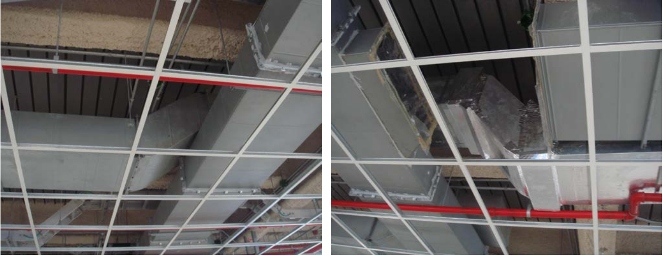
管線高程協調施工例
