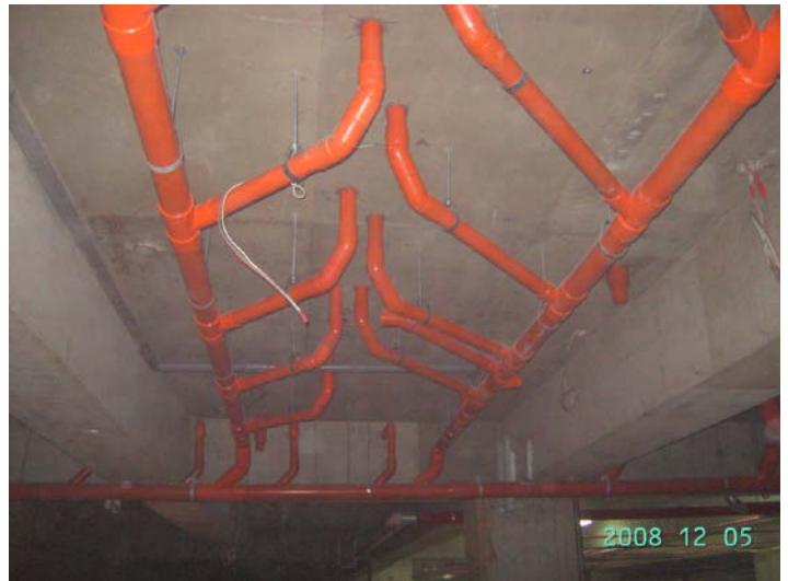
排水管路順暢排水與洩水坡度之施工
