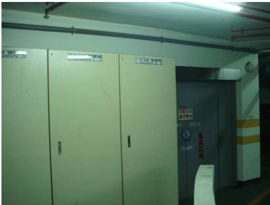
配電場所旁設置受電箱例
