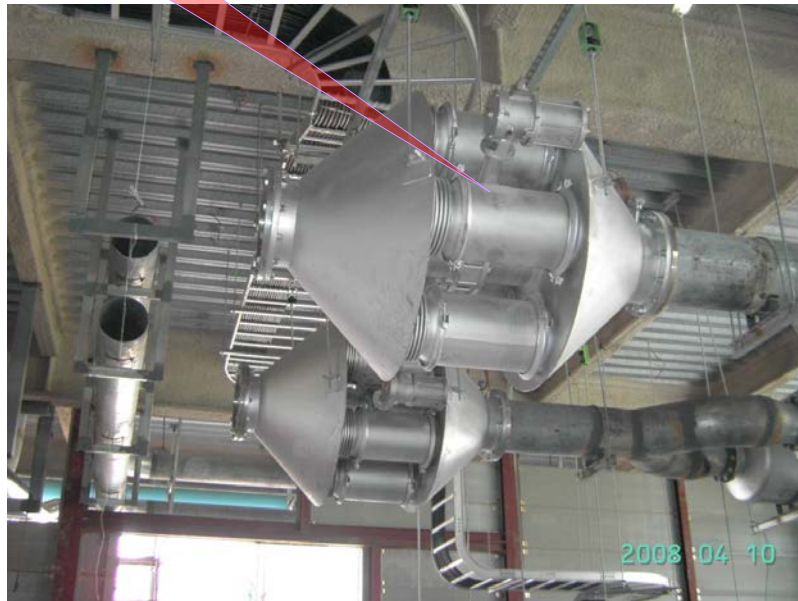
發電機煙囪淨化器安裝例
