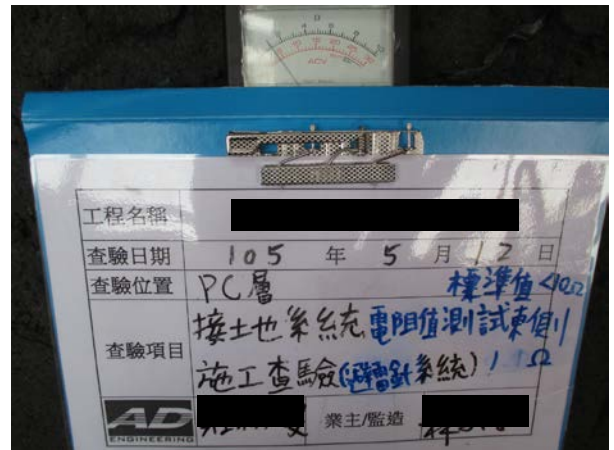
接地施工查驗例(二)
