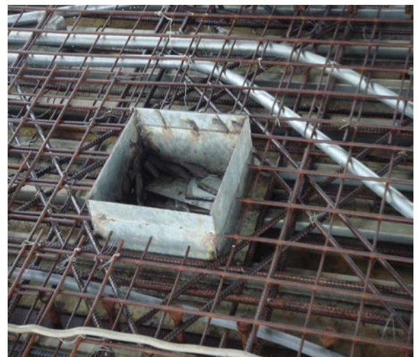
風管預留套管並加補強鋼筋
