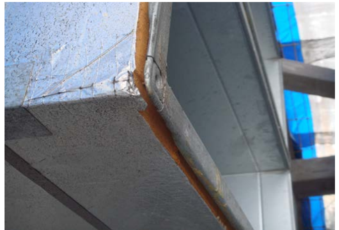
防火保溫材之施工例
