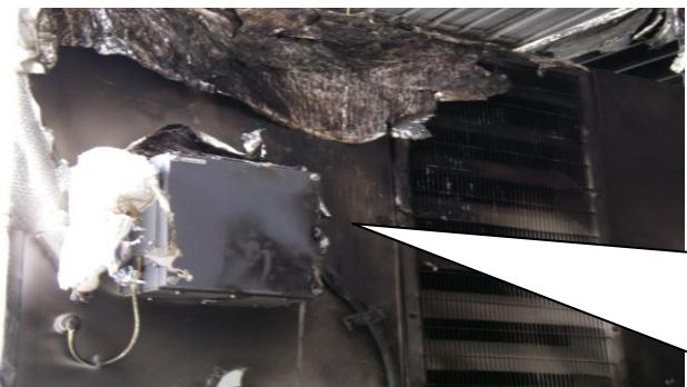
因土木、管路等工程電鋸施鋸時，鋸渣掉落於浪板鐵皮後，再滑落於下層塑料易燃物（帆布）起火悶燒，造成緊急柴油引擎發電機組之控制箱電纜等設備污損。
