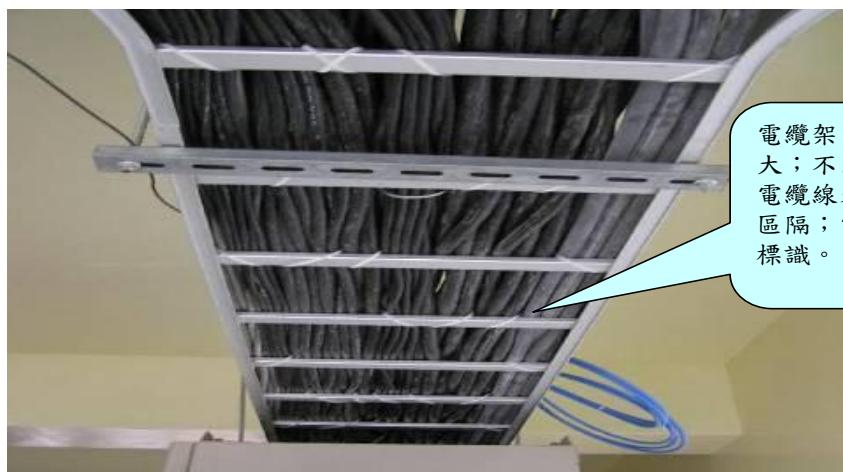
電纜架負荷太大；不同電壓之電纜線未予分離區隔；電纜架未標識。
