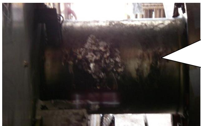
因土木、管路等工程電鋸施鋸時，鋸渣掉落於浪板鐵皮後，再滑落於下層塑料易燃物（帆布）起火悶燒，造成緊急柴油引擎發電機組之引擎轉軸等設備污損。
