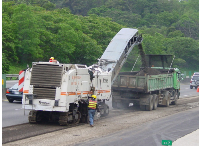
圖 29 冷式刨除機刨除損壞舊瀝青路面
