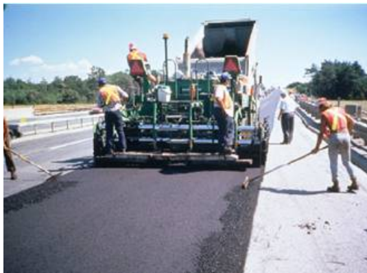
圖 22 鋪築瀝青路面
