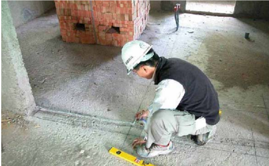
砌磚圖 1 砌牆地面清潔
