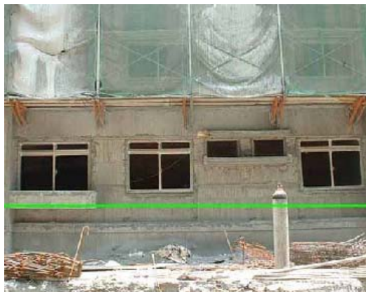
鋁門窗工程圖 3 進出基準線
