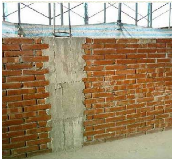
砌磚圖 8 依建築技術規則 140 條規定牆身長度與補強要求：牆身兩端支持於鋼筋混凝土補強柱時，牆身長度為其牆厚倍數之規定如下表：
