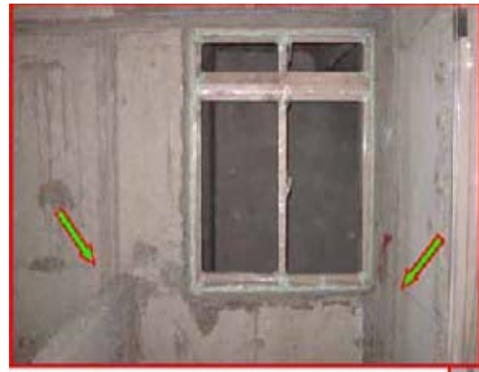
鋁門窗工程圖 4 高度基準線
