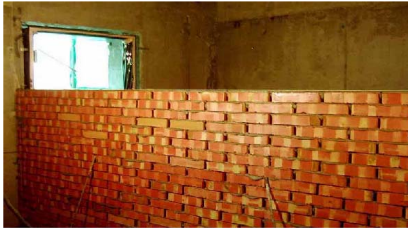
砌磚圖 5 每天砌築高度以 1.5m 為度、每皮交丁
