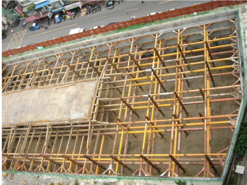
圖 4-6 順打工法現場施做情形
