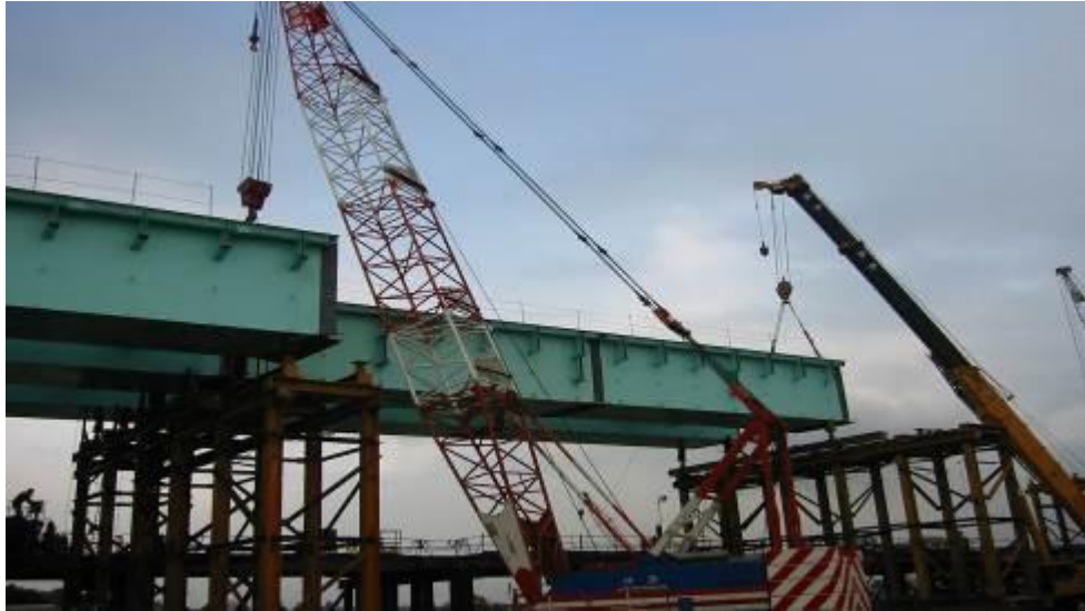
圖 3-44 吊車吊裝
