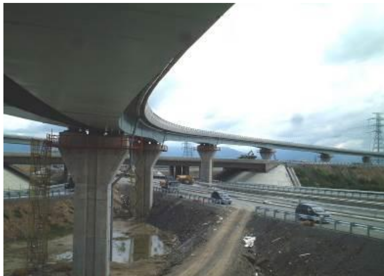
圖 3-47 鋼橋安裝完成情形
