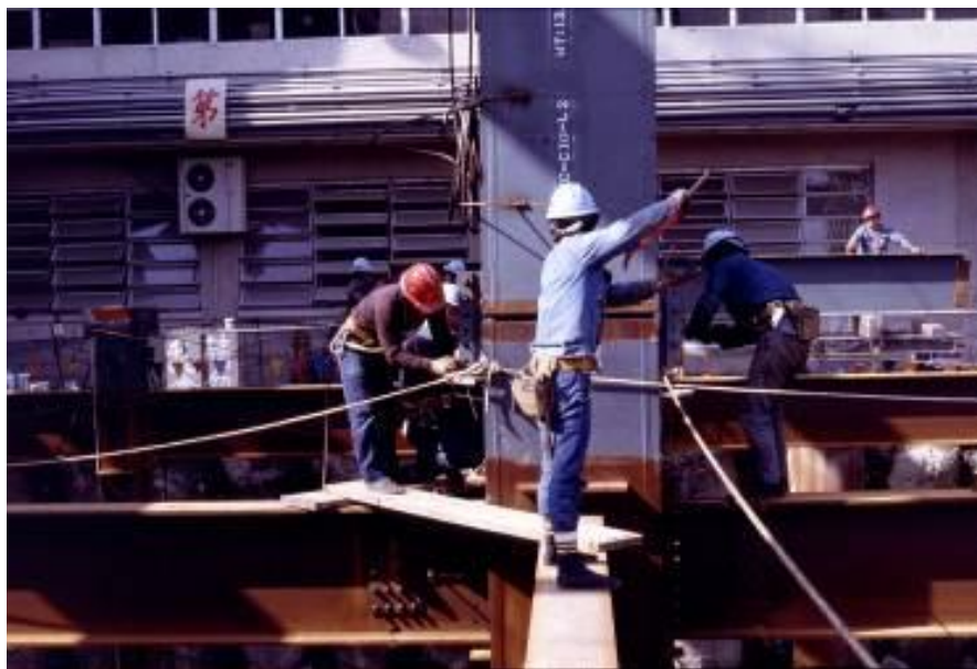
圖 3-39 鋼柱吊裝時的指揮工作
