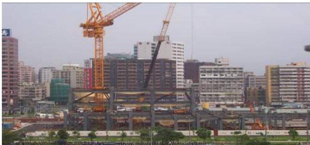
圖 3-43 鋼骨大樓吊裝
