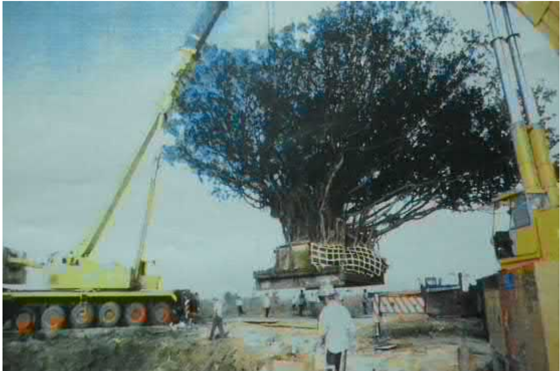
圖 III-5.特製捆紮帶配合緊迫器之使用，捆紮固定根球後，再以大型起重機、托板車吊掛運送。(廖秋成，2001.7)
