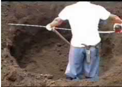
a.丈量挖掘種植之植穴大小
