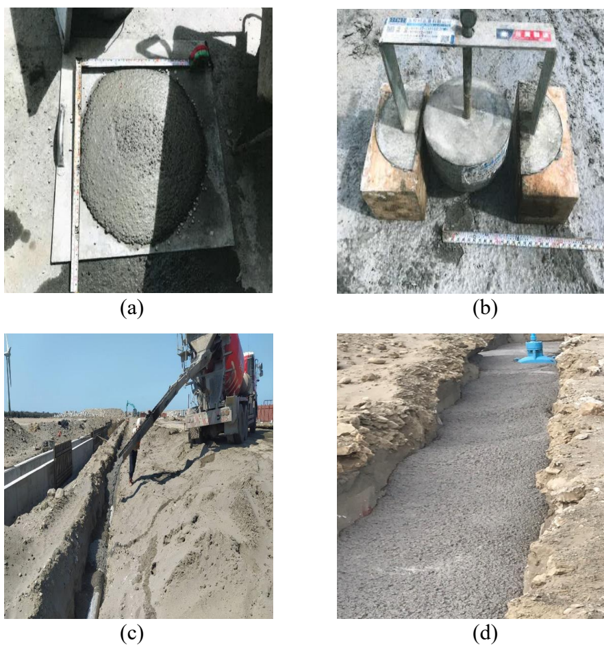
圖 6-6 案例(二)道路及公共設施工程管路回填((a)坍流度試驗，(b)落球試驗，(c)澆置中，(d)澆置完成)
