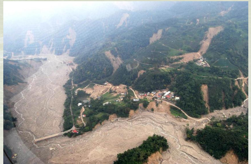
橋梁遭洪水、土石流沖毀
