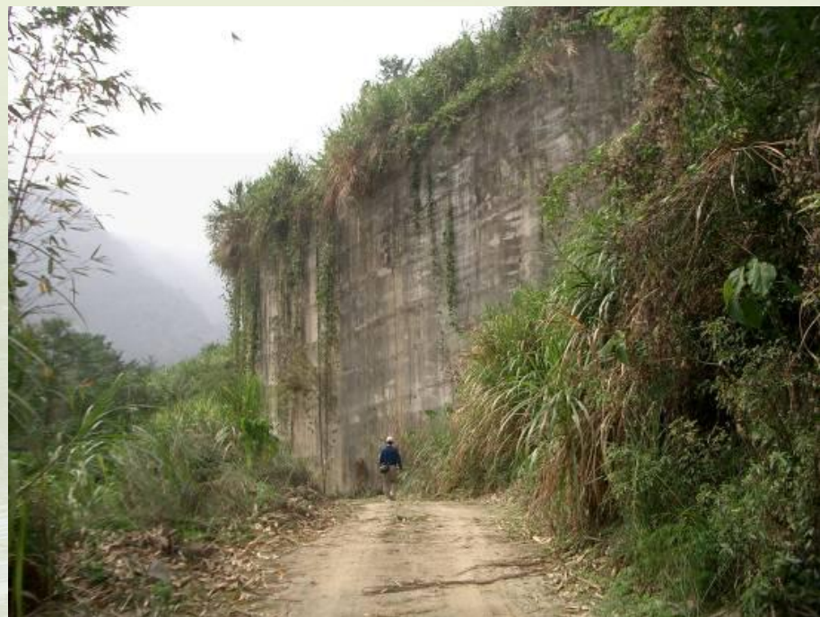
擋土牆高度太高水平抵抗而位移
