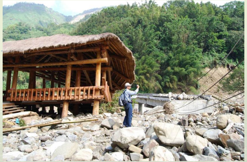
橋梁遭洪水、土石流沖毀
