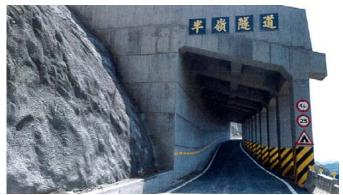
106年6月豪雨某縣山區道路災修工程,災損路段長約85公尺,因坍路百嚴重,核定4,253萬元改採200公尺明隧道辦理。
