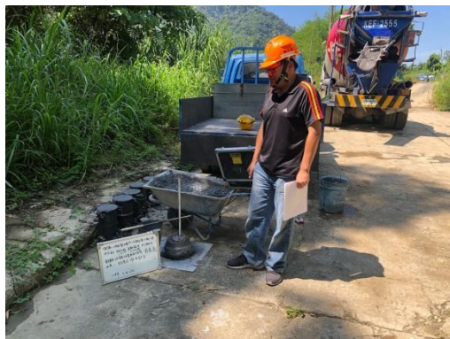
混凝土試體取樣
