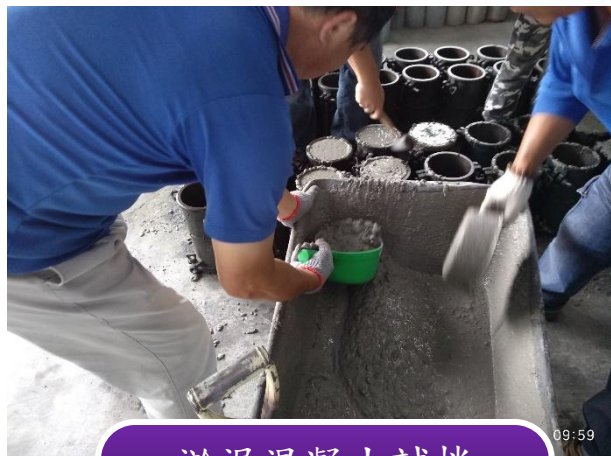
淤泥混凝土試拌
