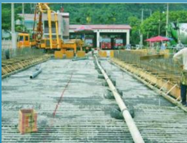
現場泵送澆置作業
