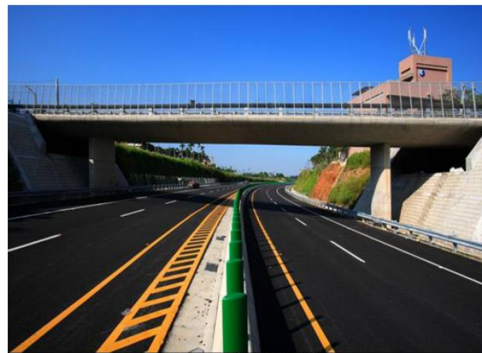
照片 4 石灼巷跨越橋完工後實景
