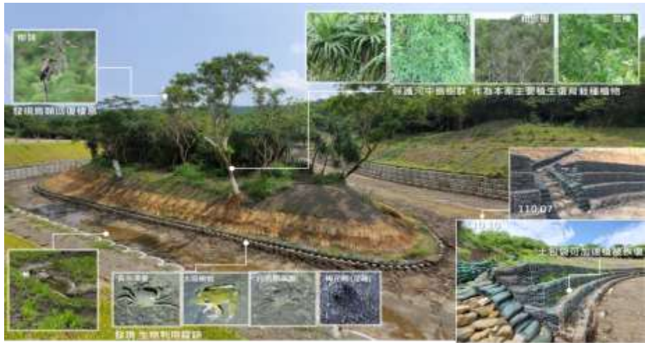
圖號7 順應河相、低 矮化護岸保護 河中島
