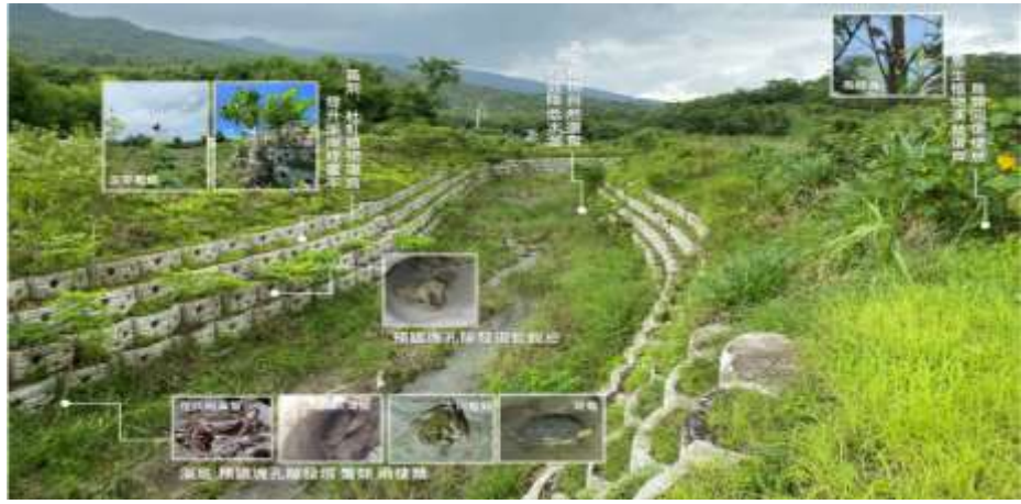
圖號6 多孔隙設計營 造生物友善棲 地
