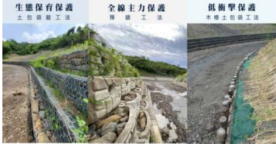
圖號3 多元緩坡化護岸
