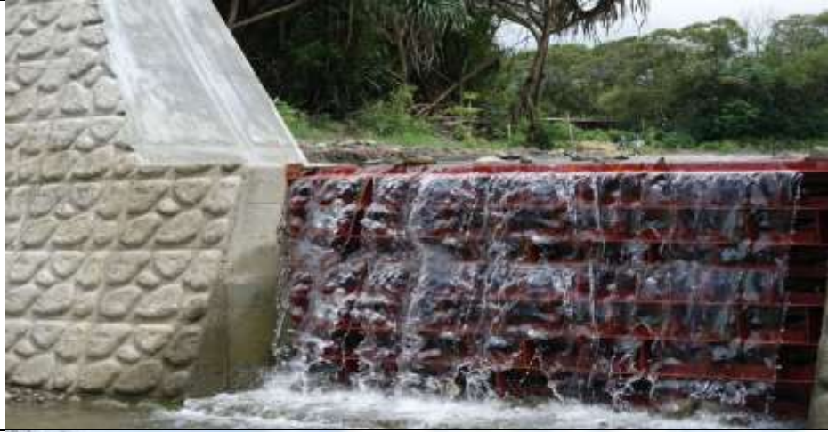
圖號9 多孔隙 微環境 過濾水 流降低 濁度
