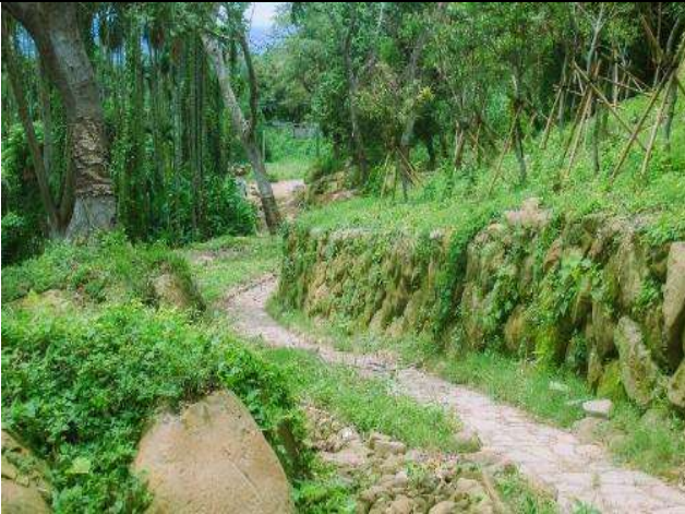
[減輕]以砌石擋土牆保留多孔隙微棲地
