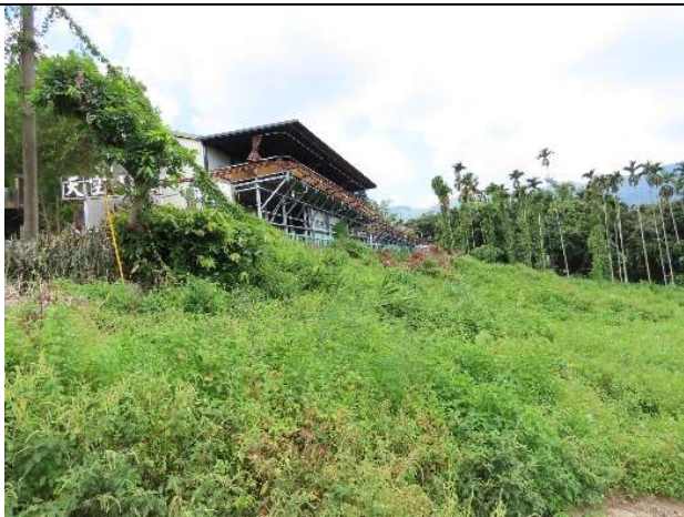
照片1. 預計施作砌石護坡牆面 (111.06.20)
