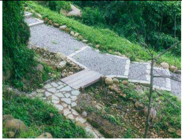
[迴避]採柔性工法施作，使用高透水性鋪面
