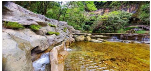
圖號 4 溝渠內凹設計，提供水生動物躲藏空間
