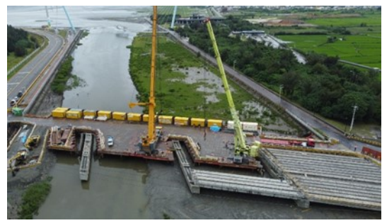
圖 2 預鑄梁吊裝施工
