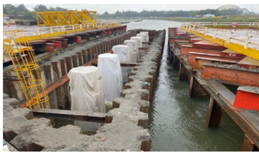
圖 1 橋墩施工圍堰情形
