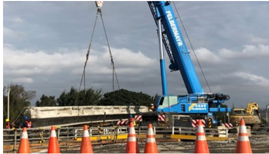
圖 3 舊橋切割後吊離河道打除
