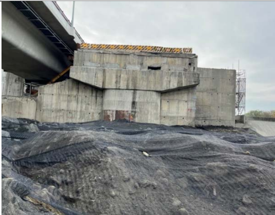
圖 17-防塵網鋪設
