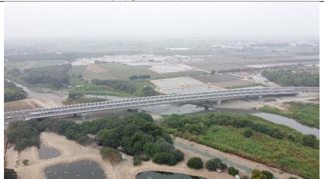
圖4-環境照-北岸落墩位置
