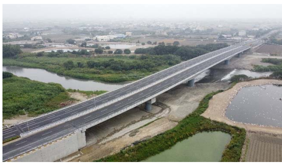
圖1-環境照-北岸落墩位置
