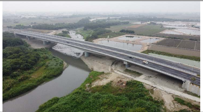
圖2-環境照-北岸落墩位置
