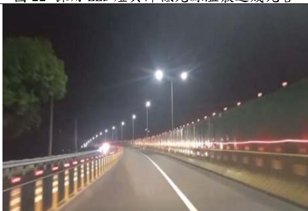
圖 24-施工圍籬外牆面夜間警示
