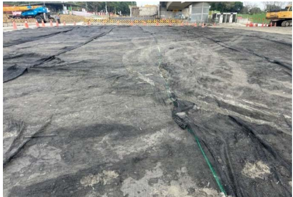
圖 18-防塵網鋪設
