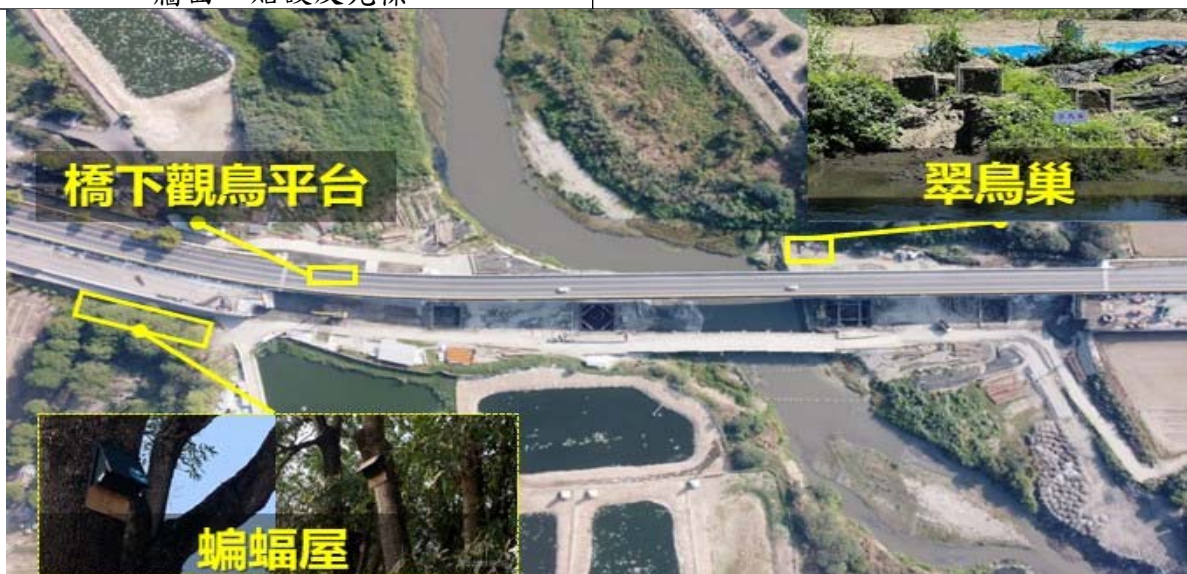
圖 25-橋下觀鳥平台、蝙蝠屋及翠鳥巢設置
