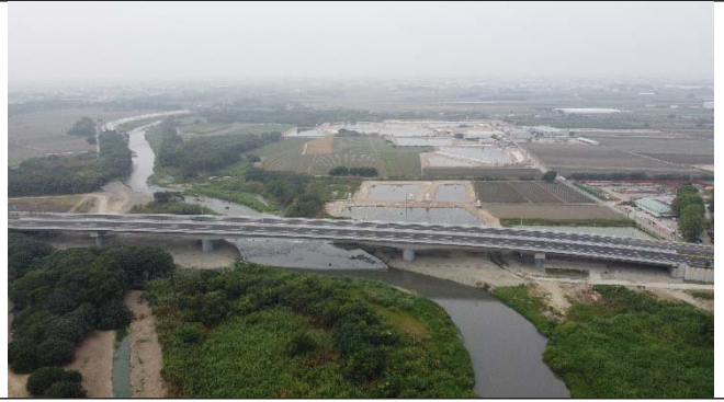
圖 6-環境照-墩柱跨越深水區
