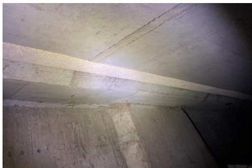
國3 359k+234鹽水溪橋進行施工期間半半施工後利用纖泥版增加蝙蝠可棲息空間。
