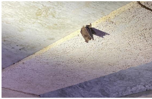
圖3 359k+234 鹽水溪橋施工後蝙蝠棲地調查，臺灣小蹄鼻蝠返回原箱室利用纖維版棲息情形。
