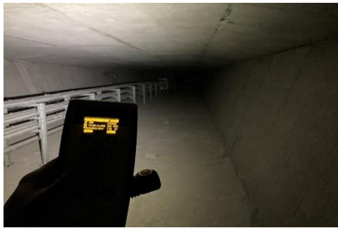
國8高架橋(東西向)1K+622~3K+837進行施工期間蝙蝠監看蝙蝠超音波偵測器使用。
