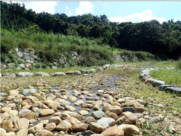
圖號 5 以乾砌石結合木樁設置固床工
