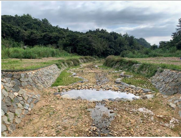
圖號7 設置砌石護岸，石縫回填表土，完工後植生快速覆蓋
