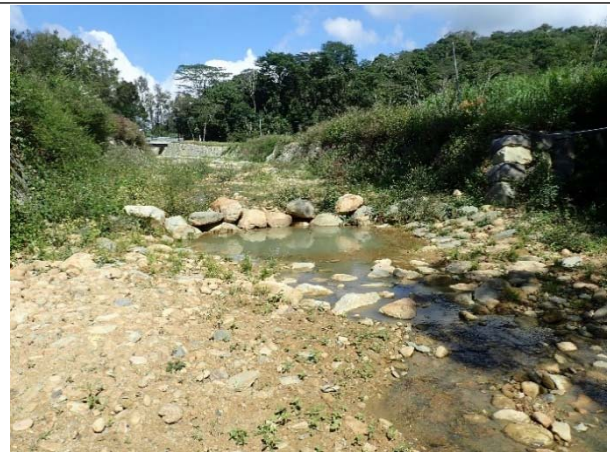
圖號 6 固床工下游營造潭區，提升水域棲地多樣性
