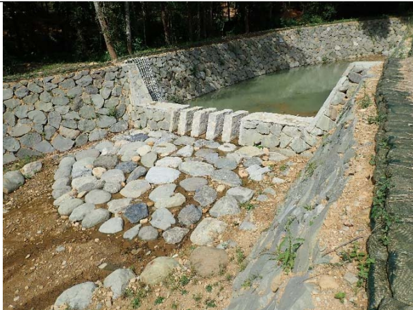
圖號 3 囚砂區固床工設計為梳子壩，下游側拋塊石為緩坡，使縱向無落差
