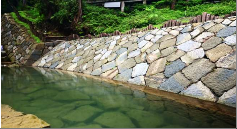
圖號3 緩坡化 護岸
