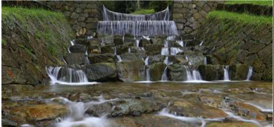
圖號4 原石堆 之階梯 跌水工
