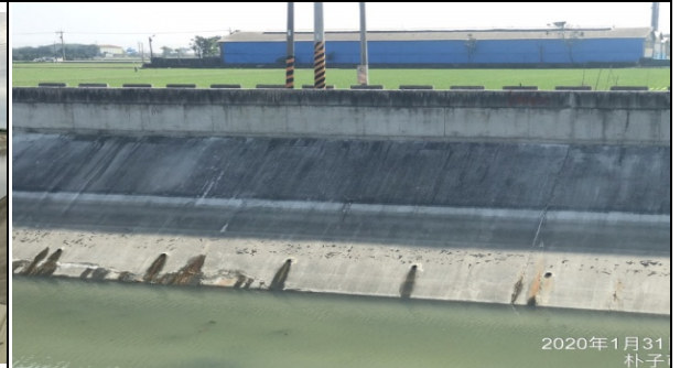
坡面工增設洩水孔
