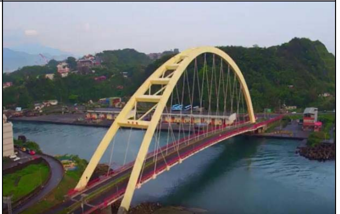
和平島箱型鋼拱橋完成圖 (資料來源：基隆市政府提供)
