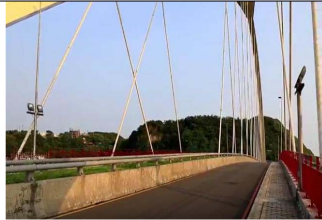
和平島聯外橋梁驗收完成後情形 (資料來源：基隆市政府提供)
