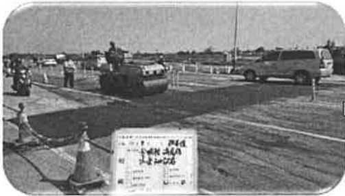
改善中：全車道刨鋪改善
