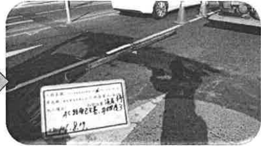
改善後：3米直規量測臨鋪平
