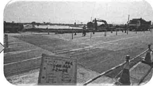
改善後：路面下陷改善完成
