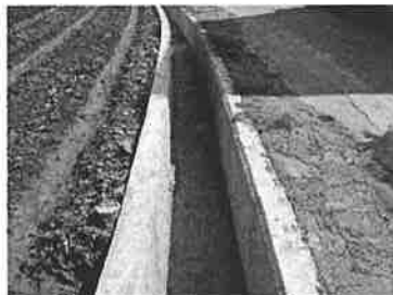
渠底清淤完成
