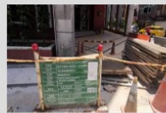
工程告示牌修改前 審查通過 基隆市政府工務處
