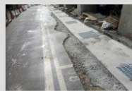
施工完成路段路面修補前 審查通過 基隆市政府工務處
