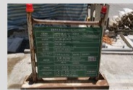
工程告示牌修改後 審查通過 基隆市政府工務處
