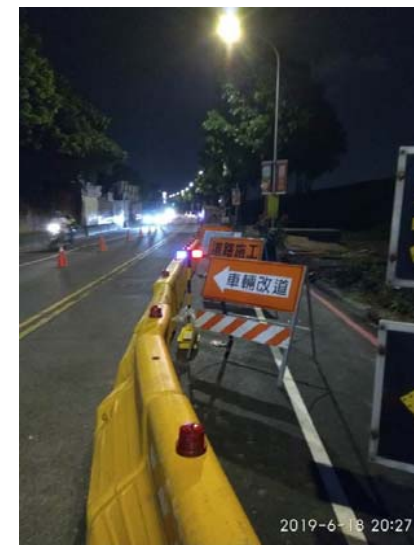
職安夜間查核 (交維設施)
