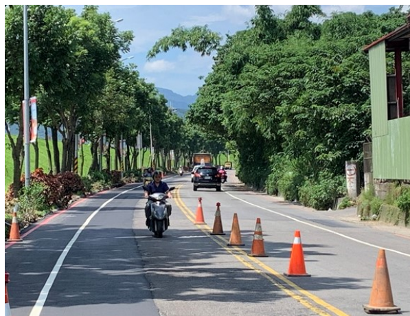
職安日間查核 (交維設施)
