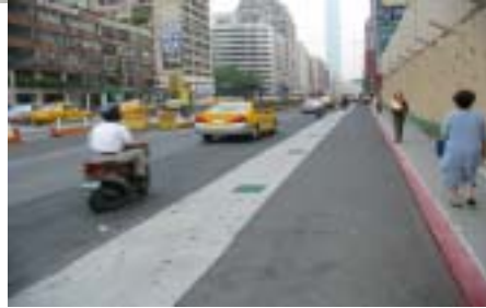
道路標線不明確
