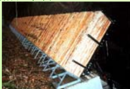
落石防止緩衝工
