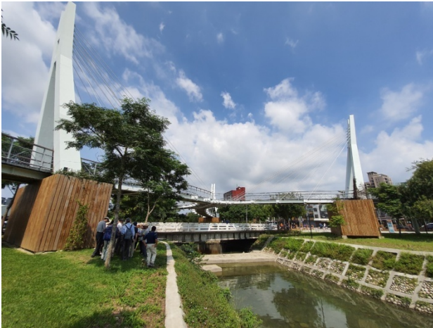
圖 3. 現場完工照片
