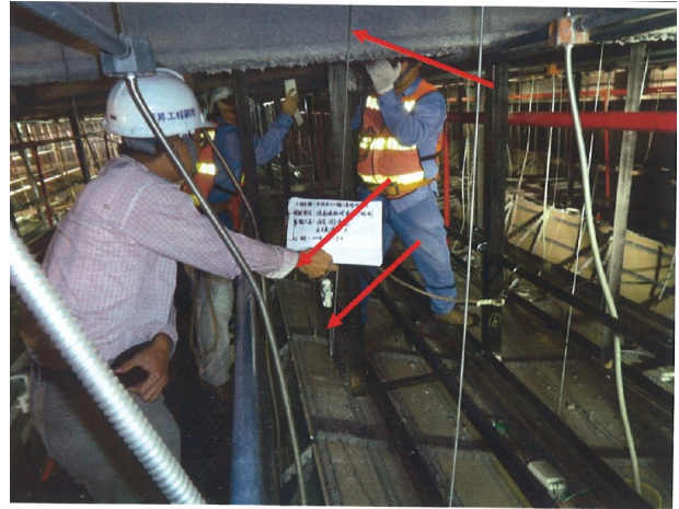
圖 4. 施工空間侷促
