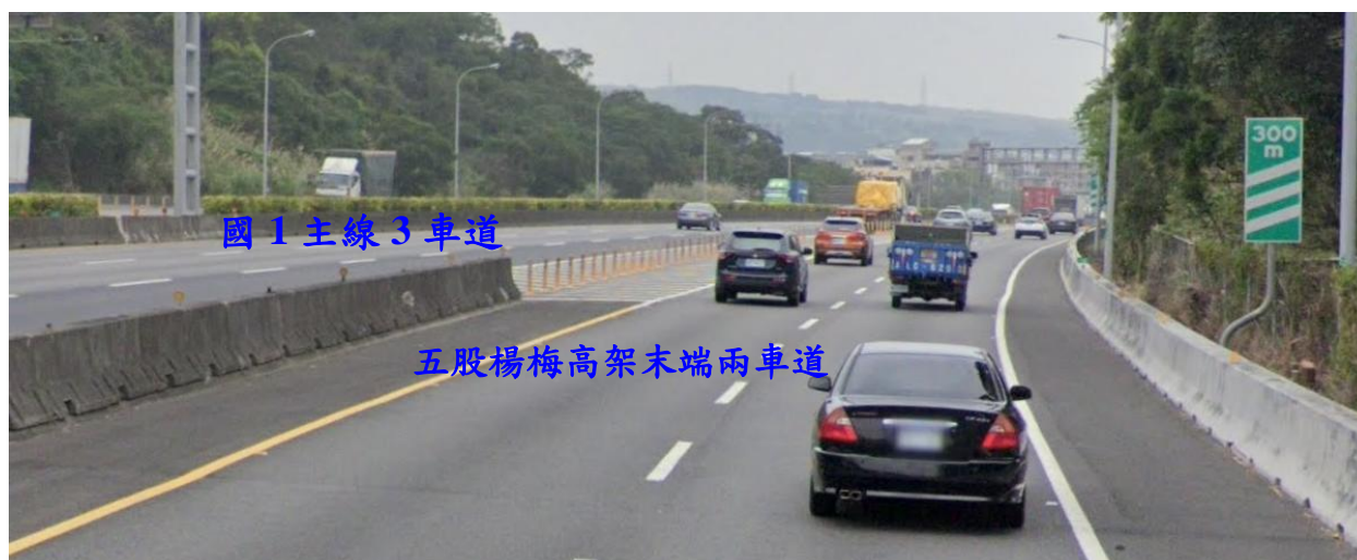
五楊高架楊梅端 2 車道匯入國 1 主線之 3 車道
