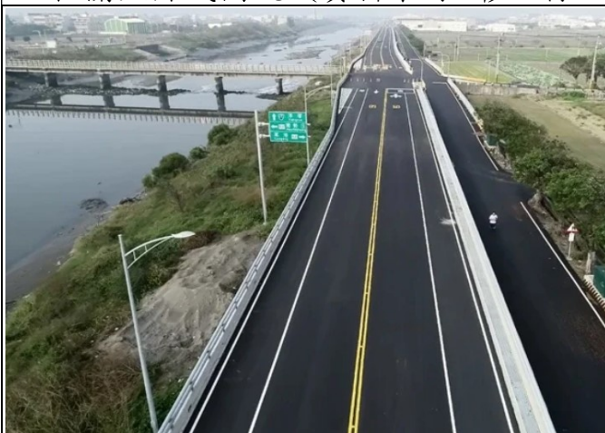
洋仔厝溪堤岸道路現況
