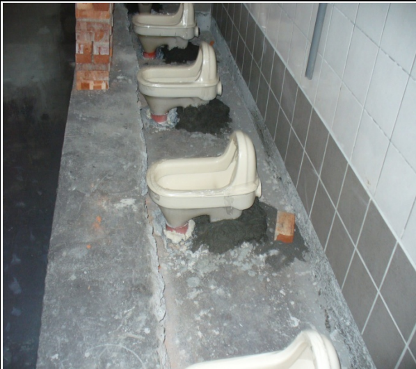
說明：廁所地坪尚未墊高，牆面磁磚已施作完成(國立宜蘭大學提供)
