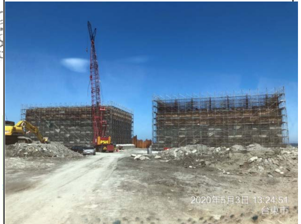
圖 2、沉箱製作情形
