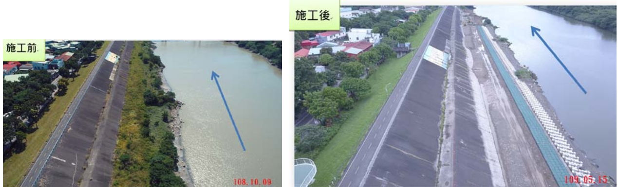
圖 2 左岸高灘地堤防基礎保護施工前後情形
