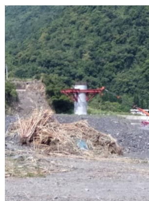
P2 橋墩施工完成
