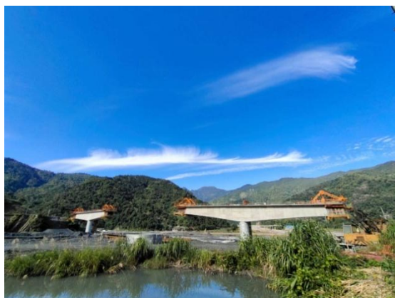
橋樑上部結構施工照片
