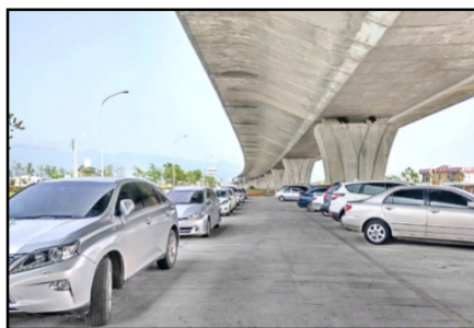
圖一：國道 5 號高架橋下共乘停車場使用情形
