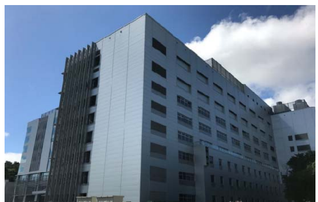
國家生技研究園區 A 棟照片
