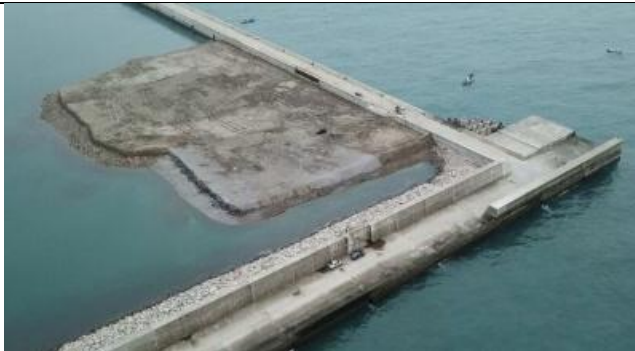
圖1 煉鋼爐渣轉爐石運用於填海造地試辦及驗證作業
