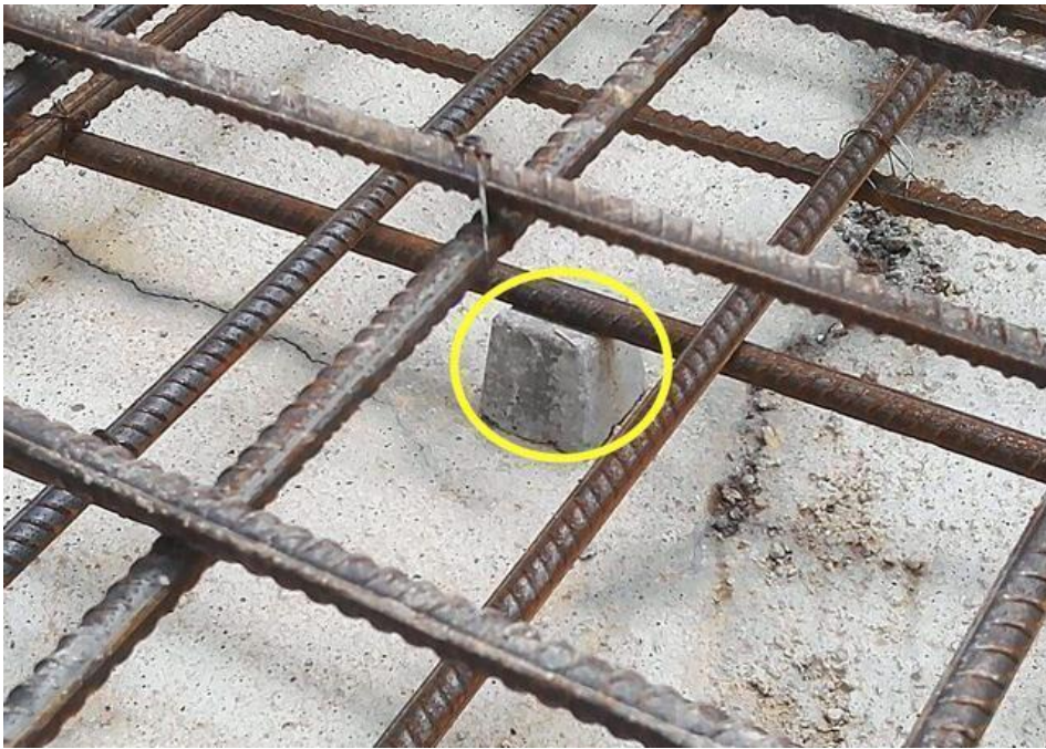
圖：鋼筋保護層墊塊
